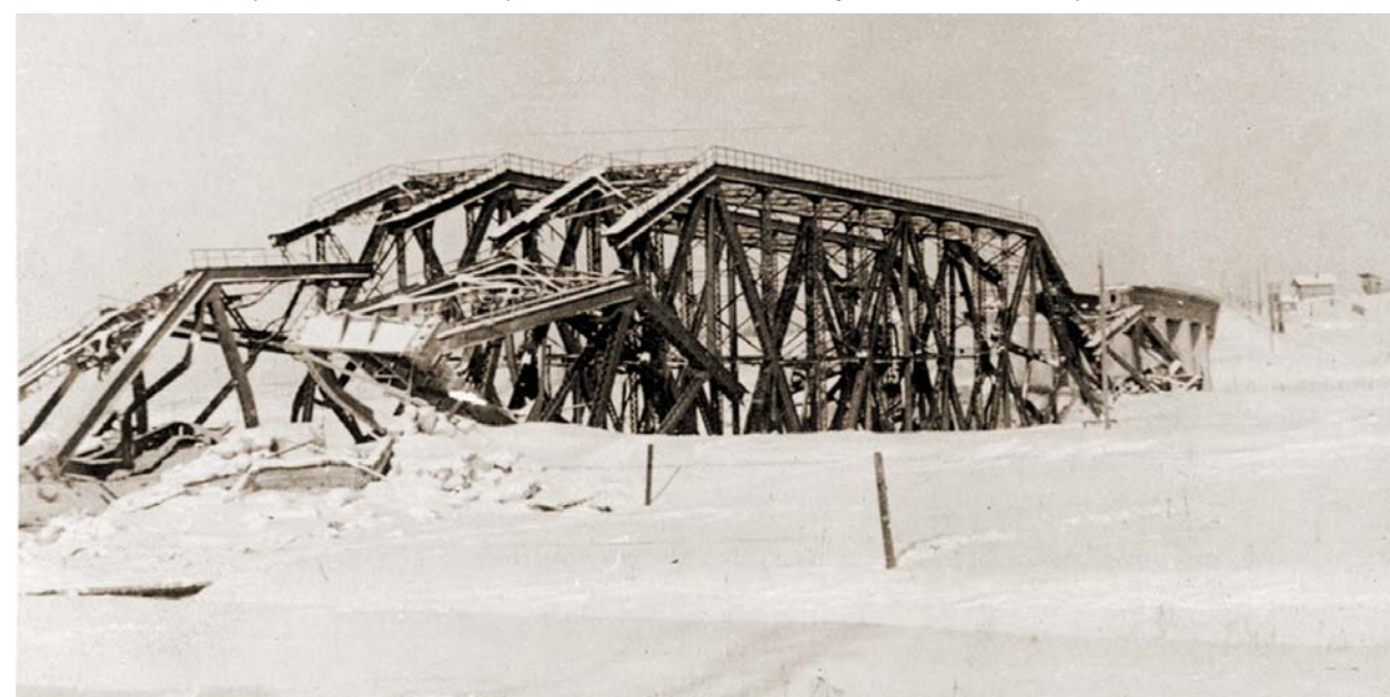
Взорванный мост через канал им. Москвы у Деденева, ноябрь 1941 г.
